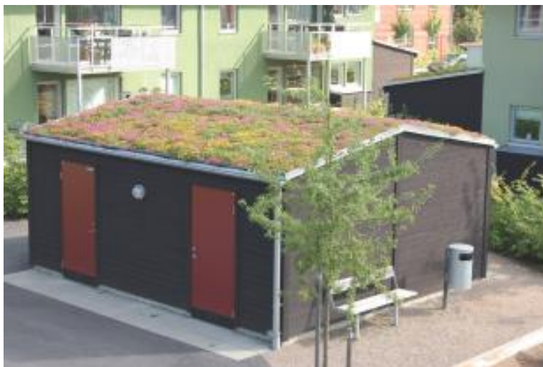
Figur 17. Exempel på grönt tak (bildkälla: vegtec.se)
