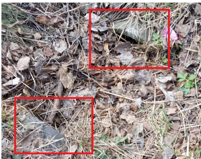
Figur 4. Omarkerad trumma invid detaljplanen, antas avvattna Brandbergsleden.
