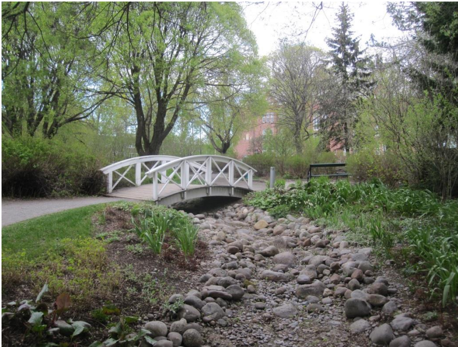
Figur 14. Ett öppet fördröjningsstråk i Vänortsparken i Umeå som det låtits bygga en bro över för att underlätta för passerande.
