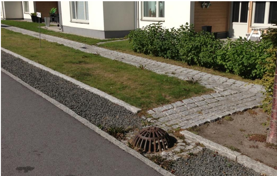
Figur 12. Exempel på infiltrationsstråk i urban miljö.
