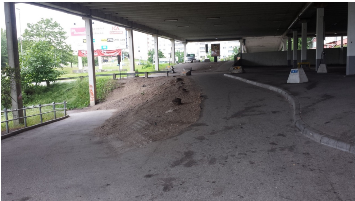
Bild 9: Gång- och cykelvägen går i en tunnel under Brandbergsleden för att komma upp under parkeringsdäcket där inlastningen till centrum finns. Foto: Karin Österdahl
