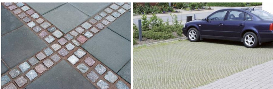
Figur 13. Gles plattsättning med sandfug och gräsarmering är två exempel på ytbeläggningar som minskar avrinningen.
