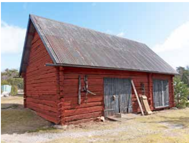
Äldre ladugårdsbyggnad vid Nåttarö gård 2019. Foto: Helena Wärnhjelm, Haninge kommun.
