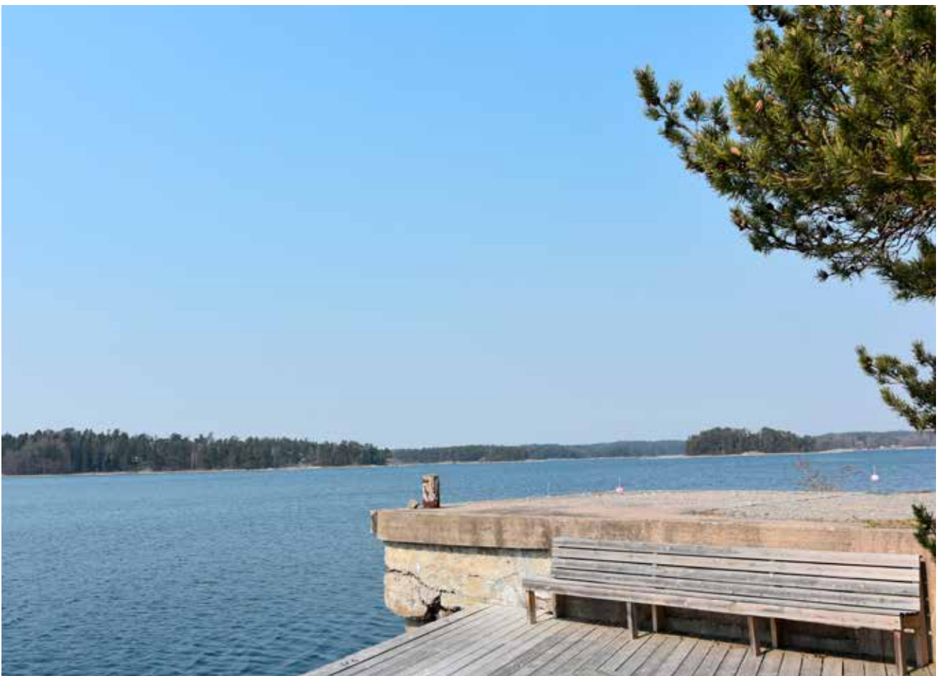
Betongfundament efter ångbåtskajen vid Furunäsudden. Foto Moa Andersson WSP
