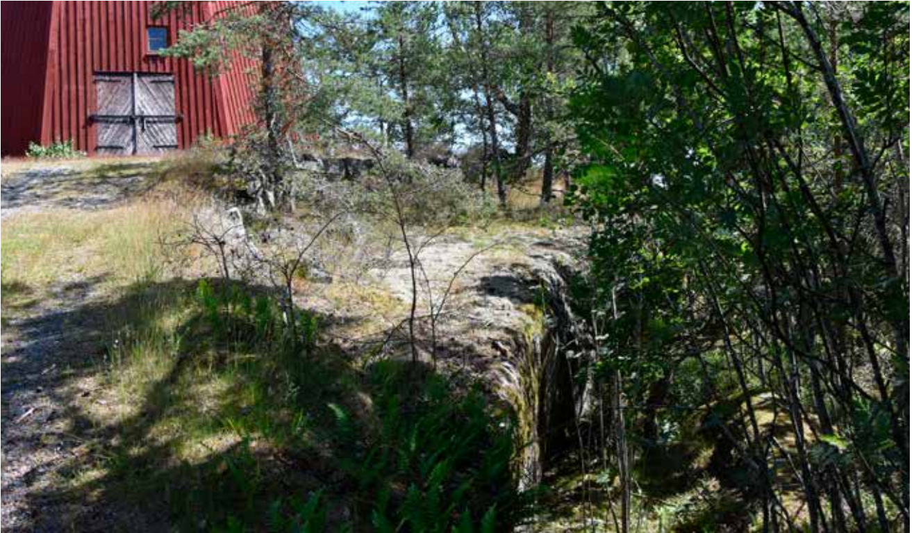
Bevarad del av grundfundament till den ursprungliga kvarnen från 1700-talet. Foto Moa Andersson WSP
