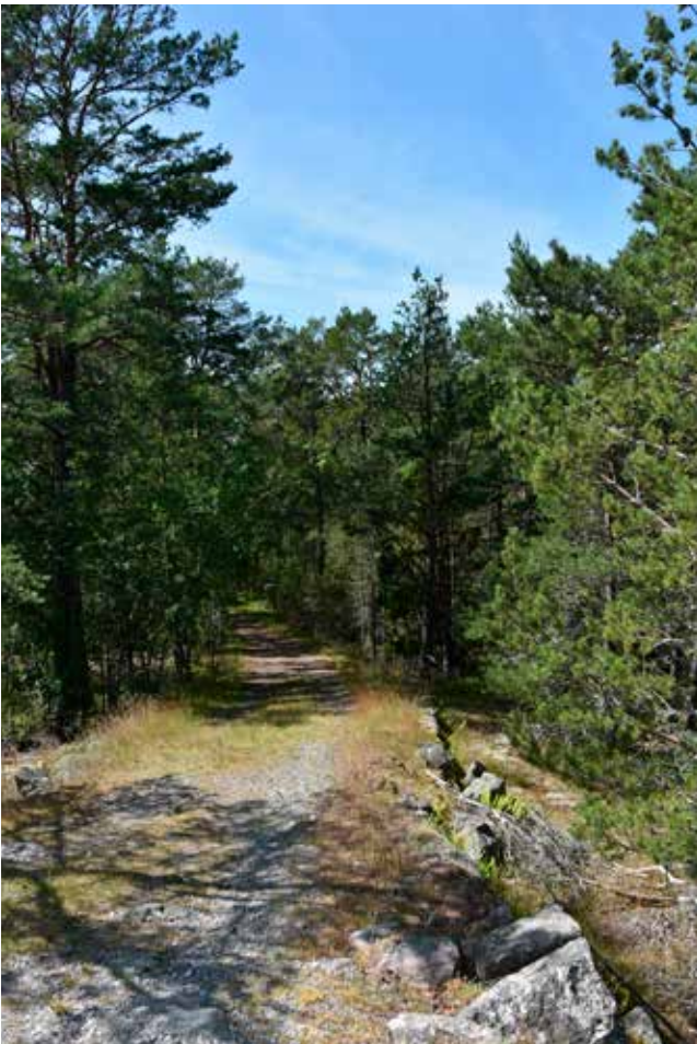
Den bevarade vägen som byggdes med hjälp av militärer under Carl Christian Gyldenens tid under 1700-talet. Foto Moa Andersson WSP
