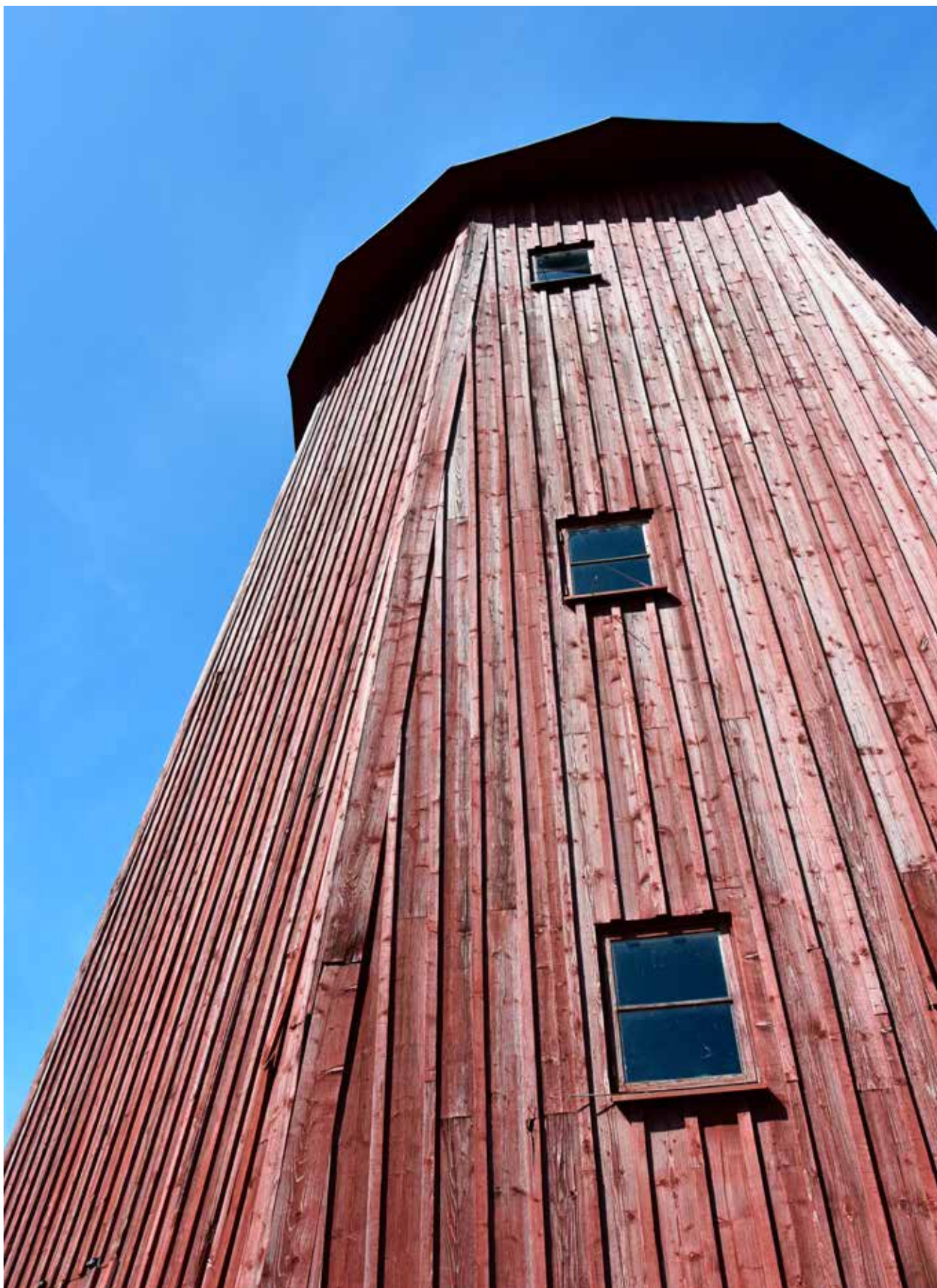
Kvarnen brann ner på grund av ett blixnedslag 1988, men återuppbyggdes två år senare i samma utförande. Här syns tydligt byggandens typiska stående locklistpanel med små enluftsfnster med enkel spröjs. Foto Moa Andersson WSP
