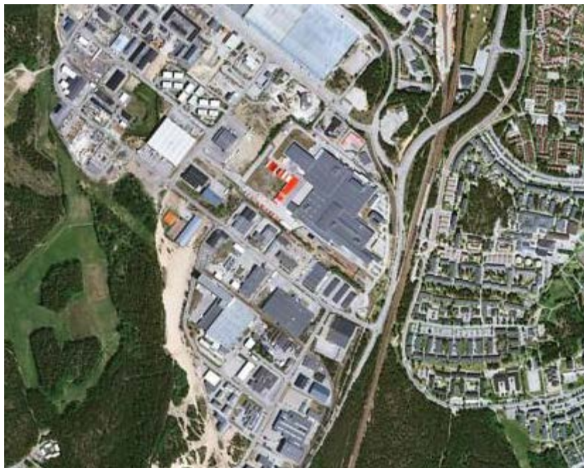
Bild 5 Jordbro industriområde ligger i en sänka i landskapet och riskerar att översvämmas vid kraftig eller långvarig nederbörd, se även Karta 3.
