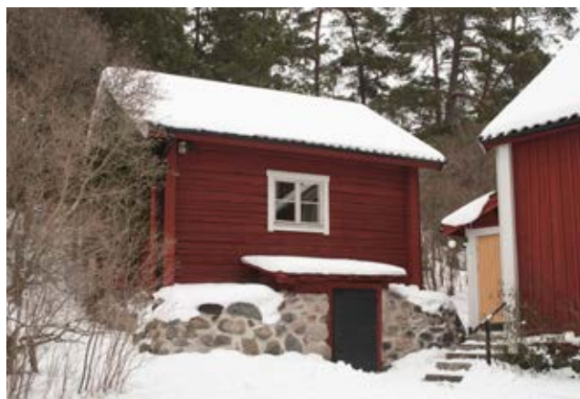
Källarboden är en av de äldre byggnaderna på Degernäs Foto: WSP, Paulina Virta
